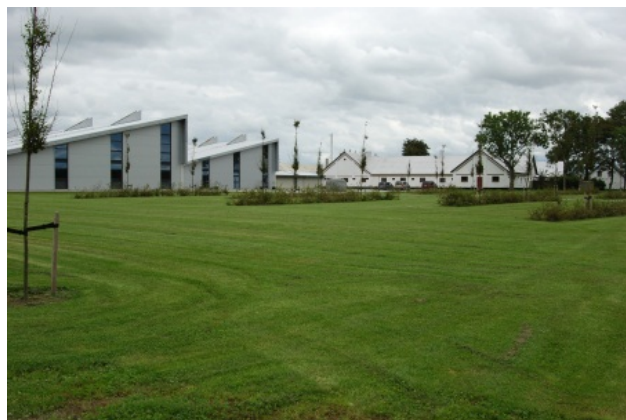
Sammenbygning af nyt og eksisterende staldanlæg.
